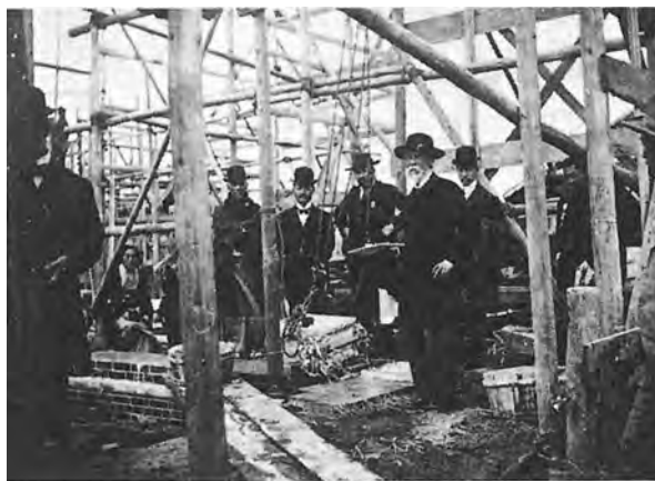
礎石のそなえつけ作業（明治37年1月2日） 中央ひげの人、市左衛門、後列左から大倉孫兵衛、 村井、飛鳥井、大倉和親
