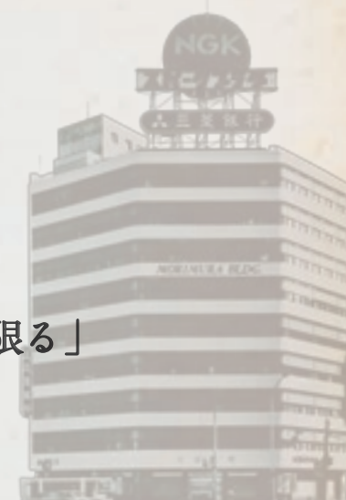
森村ビル全景(虎ノ門)
